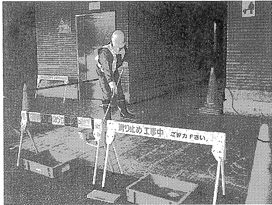
防滑工事の施工風景。タイルなどの床材を滑りにくくしている
